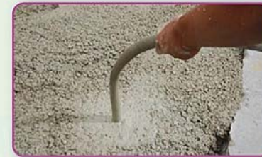
รูปการอัดแน่นคอนกรีตโดยใช้เครื่องจี้เขย่าแบบหัวจุ่ม
