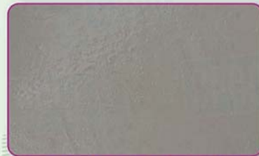
ผิวคอนกรีตที่มีน้ำปูนที่ผิวหลังจากการจี้ยาที่ดี
