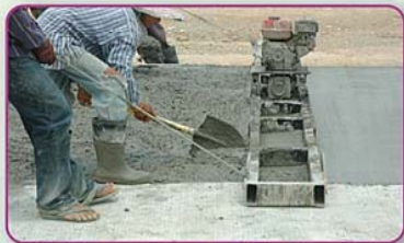
รูปการใช้เครื่องจี้ยาที่ผิวหน้าคอนกรีต
