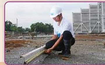
รูปการวัดขนาดแบบหล่อและการตั้งลูกน้ำ
