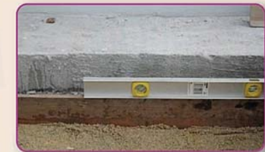
รูปการวัดขนาดแบบหล่อและการตั้งลูกน้ำ
