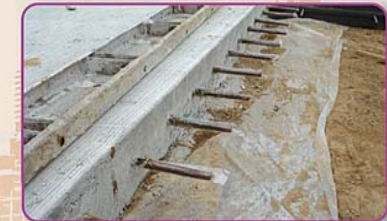
การทำรอยต่อก่อสร้างและการเสริมเหล็กเดือย
