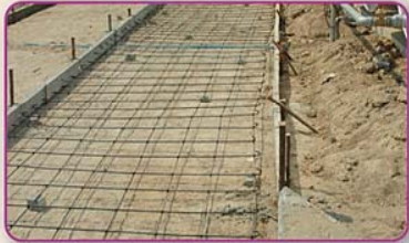
การเสริมตะแกรงเหล็กกันร้าว
