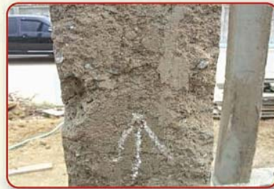
ความเสียหายจากการถอดแบบเร็วเกินไป
