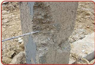
ความเสียหายจากการถอดแบบเร็วเกินไป
