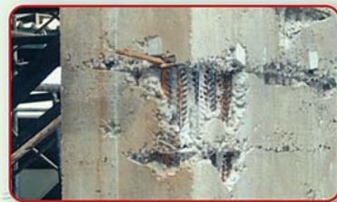
การจัดยาคอนกรีตไม่ถูกวิธีทำให้เสาคอนกรีตเกิดโพรง
