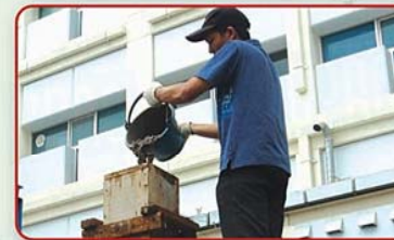
การเทคอนกรีตโดยการใช้อ่างและใช้กระบะ (Bucket) เท
