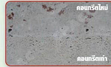
การแบ่งชั้นของคอนกรีต (Cold Joint)
