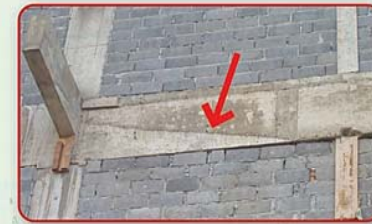
การแบ่งช่วงการเทคอนกรีตที่ผิดวิธี ไม่แบ่งช่วงตั้งฉากกับท้องคาน
