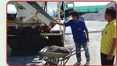
การลำเลียงคอนกรีตด้วยสายพานและรถเข็น
