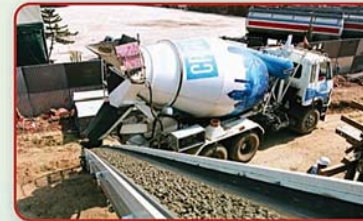
การลำเลียงคอนกรีตด้วยสายพานและรถเข็น
