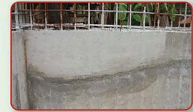
การแบ่งชั้นของคอนกรีต (Cold Joint)
