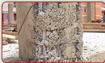
การจัดยาคอนกรีตไม่ถูกวิธีทำให้เสาคอนกรีตเกิดโพรง
