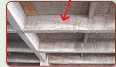
การแบ่งช่วงการเทคอนกรีตที่ผิดวิธี ไม่แบ่งช่วงตั้งฉากกับท้องคาน
