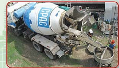
การเทคอนกรีตโดยการใช้อ่างและใช้กระบะ (Bucket) เท
