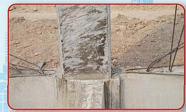
การตั้งแบบหล่อก็ไม่เหมาะสมทำให้เสาและคานไม่อยู่ในแนวที่กำหนด
