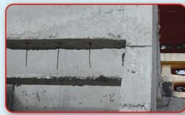
การตั้งแบบหล่อก็ไม่เหมาะสมทำให้เสาและคานไม่อยู่ในแนวที่กำหนด
