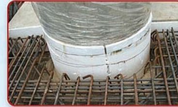
การทำรอยต่อระหว่างพื้นกับเสา และความเสียหายในกรณีที่ไม่ทำรอยต่อ
