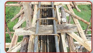
การวางเหล็กเสริมคอนกรีต
