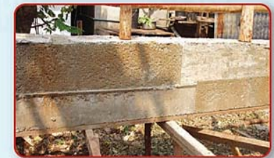
ความเสียหายที่ผิวคอนกรีตจากการใช้ไม้แบบใหม่
