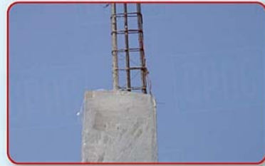
การวางเหล็กเสริมที่ไม่เหมาะสม
