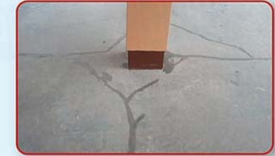
การทำรอยต่อระหว่างพื้นกับเสา และความเสียหายในกรณีที่ไม่ทำรอยต่อ
