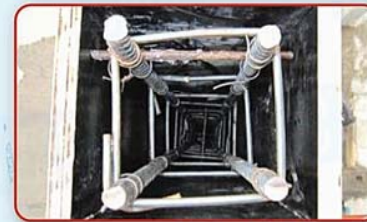
การวางเหล็กเสริมคอนกรีต
