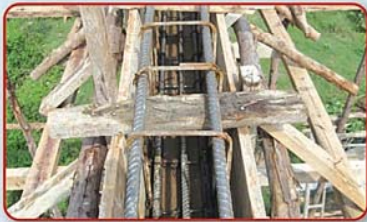
การตั้งแบบหล่อโครงสร้างที่มีค้ำยันเหมาะสม
