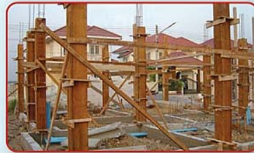
การตั้งแบบหล่อโครงสร้างที่มีค้ำยันเหมาะสม
