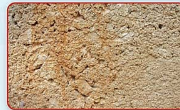
ความเสียหายที่ผิวคอนกรีตจากการใช้ไม้แบบใหม่
