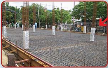
การวางเหล็กเสริมที่ไม่เหมาะสม
