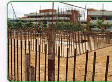
การบ่มคอนกรีตฐานรากขนาดใหญ่ ด้วยการใช้นดินหรือทรายถมที่ผิวหน้า
