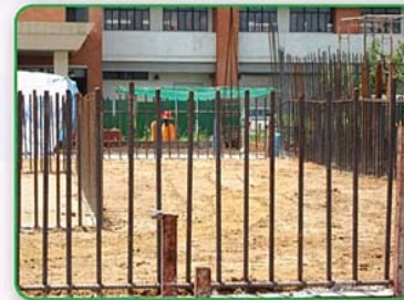
การบ่มคอนกรีตฐานรากขนาดใหญ่ ด้วยการใช้นดินหรือทรายถมที่ผิวหน้า
