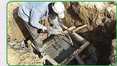
วิธีการอัดแน่นคอนกรีต
