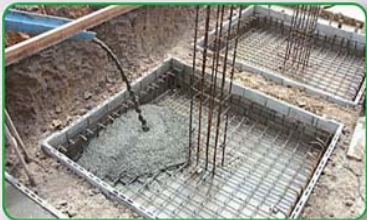
การเทคอนกรีตโดยให้มีการตกอย่างอิสระ
