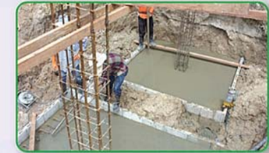
ฐานรากที่ทำการเทคอนกรีตเสร็จแล้ว
