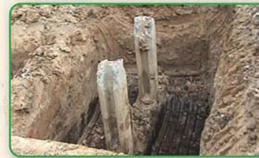
ก่อนตั้งแบบหล่อ กันหลุมต้องไม่มีน้ำขัง
