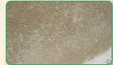
ความเสียหายจากที่ผิวคอนกรีตจากการใช้ไม้แบบใหม่
