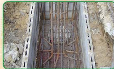
กันหลุมฐานรากไม่มีน้ำขัง
