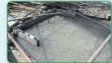
การกองดินหรือวัสดุก่อสร้างไว้ที่ปากหลุมอาจทำให้ปากหลุมทรุดได้
