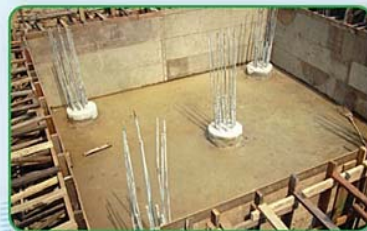
ไม่เทคอนกรีตหยาบกับหัวเสาเข็ม
