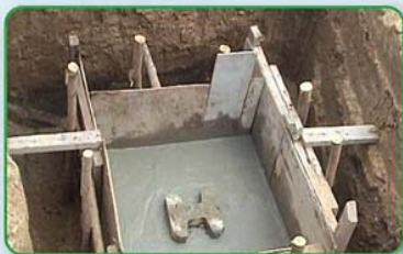
ไม่เทคอนกรีตหยาบกับหัวเสาเข็ม
