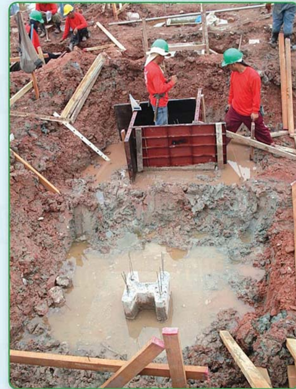
การเผื่อพื้นที่สำหรับการปฏิบัติงาน
