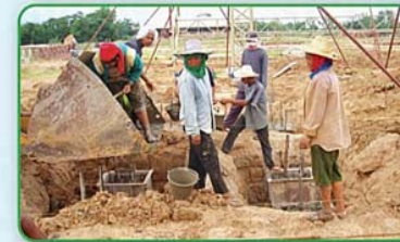
การกองดินหรือวัสดุก่อสร้างไว้ที่ปากหลุมอาจทำให้ปากหลุมทรุดได้
