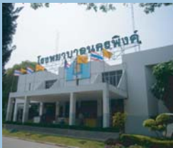
โรงพยาบาลนครพิงค์ Nakornping hospital
