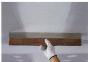
ตรวจสอบระดับงานฉาบรอยต่อหัว-ท้ายแผ่น
