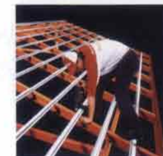
ผ่านกรรมวิธีชุบในสนิมแบบเดียวกับโครงถังรถยนต์
