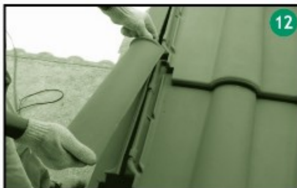
ใช้กระเบื้องจบลอนวางทับกระเบื้องหลังคาและครอบข้างซ้าย
