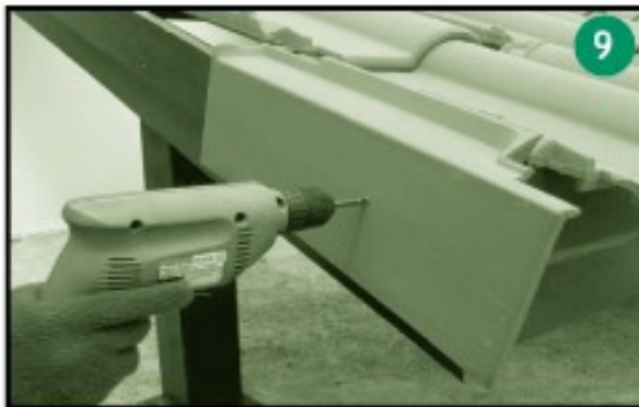
ยึดครอบข้างซ้ายด้วยสกรูเกลียวปล่อยเบอร์ 8 ขนาด 2 นิ้วจำนวน 1 ตัว
