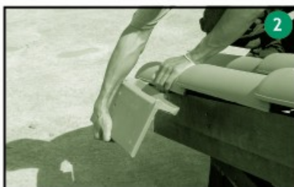
ยกกระเบื้องแผ่นแรกขึ้นเล็กน้อย แล้วสอดครอบข้าง ให้แนบไม้บัวป็นคม
