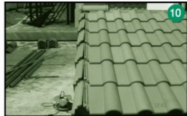
ติดตั้งครอบข้างซ้ายจนถึงสันหลังคา
