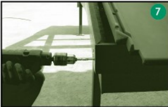
ก่อนเริ่มติดตั้งครอบข้างซ้ายให้ติดตั้งสกรูเกลียวเพื่อรองรับปลายครอบข้างซ้ายแผ่นแรกโดยให้หัวสกรูยื่นออกมา 1 ซม. เหมือนครอบข้างขวา
