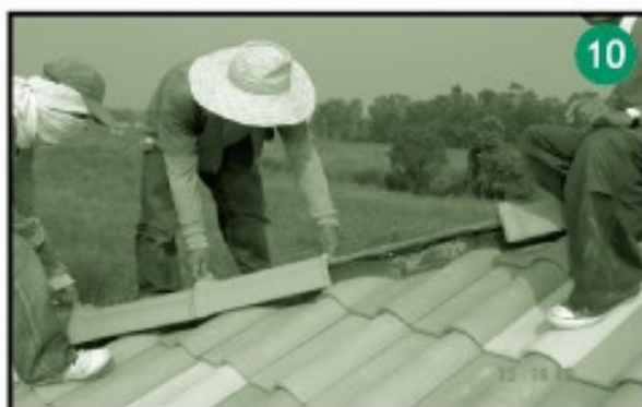
โดยให้กึ่งกลางของกรอบสันตรงกับสายเอ็นที่ขึงไว้เพื่อบังคับแนวให้ตรง
