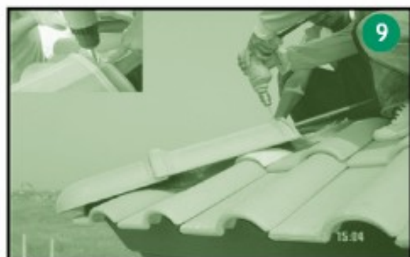
ติดตั้งกรอบสันแผ่นต่อไป โดยยึดกรอบสันกับเหล็กรับกรอบทุกแผ่นด้วยสกรูเกลียวยึดกระเบื้อง 2.5 นิ้ว-ปลายสว่านแผ่นละ 1 ตัว
