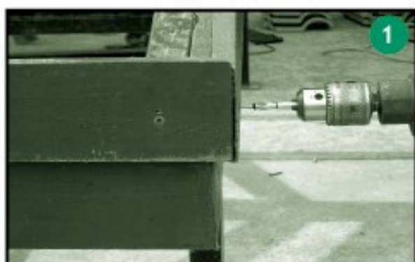
ให้ติดตั้งสกรูเกลียวเพื่อรองรับปลายครอบข้างขวา แผ่นแรกโดยให้หัวสกรูยื่นออกมา 1 ซม.
