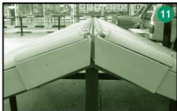
ครอบข้างซ้ายตัวบนสุดตรงสันหลังคา ตัดในแนวตั้งด้วยไฟเบอร์
