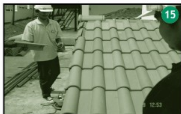
ติดตั้งกระเบื้องจบลอนแผ่นต่อไปจนถึงสันหลังคา
