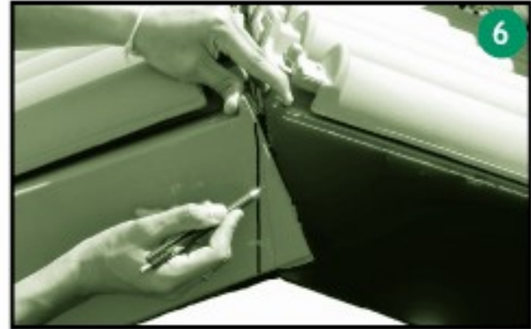
ครอบข้างขวาตัวบนสุดตรงสันหลังคา ให้ขีดเส้นเพื่อตัดในแนวตั้งด้วยไฟเบอร์
