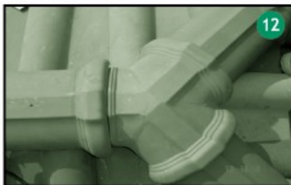
ใช้กรอบสามทาง ปิดทับรอยต่อของกรอบสันตรงแนวตะเข้เส้นบรรจบกับอกไก่ทั้ง 3 แนว และยึดด้วยสกรูเกลียวยึดกระเบื้อง 2.5 นิ้ว ปลายสว่าน แล้วใช้ซิลิโคนปิดทับหัวตะปู
