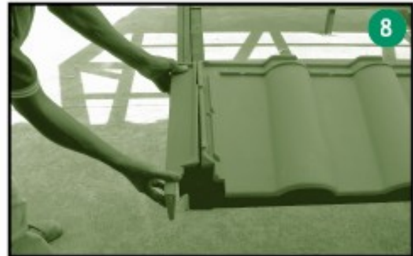
วางครอบข้างซ้าย ให้แนบไม้บัวบันลุม โดยให้มีร่องห่างกับกระเบื้องประมาณ 5 มม.เพื่อให้มีช่องว่างไว้ยึดสกรูของกระเบื้องจบลอน
