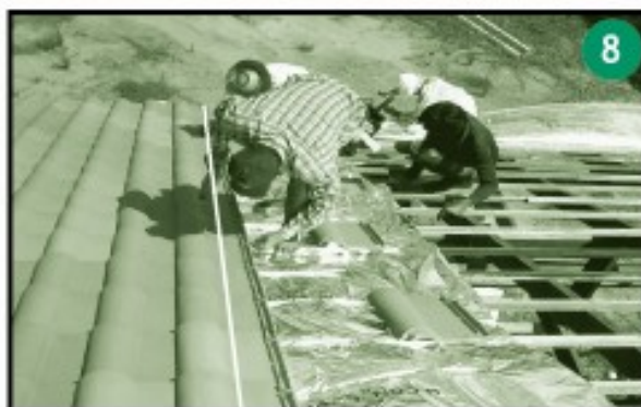
ควรชิงสายเอ็นระหว่างเชิงชายกับสันหลังคา เพื่อ บังคับแนวของกระเบื้องทุกๆ ระยะ 10 แผ่น
