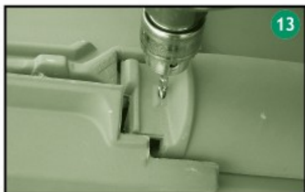
ยึดกระเบื้องจบลอนด้วยสกรู 2.5 นิ้ว ยึดกับแป
