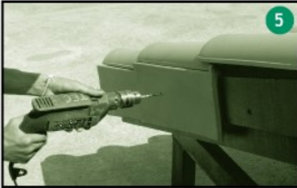
ติดตั้งครอบข้างขวาตัวต่อไปจนถึงสันหลังคา
