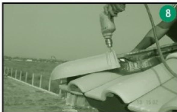
ติดตั้งกรอบปิดปลายตะเข้เส้นเป็นแผ่นแรก โดยยึดกรอบปิดปลายตะเข้เส้นกับเหล็กรับกรอบด้วยสกรูเกลียวยึดกระเบื้อง 2.5 นิ้ว-ปลายสว่านให้แน่นพอสมควร
